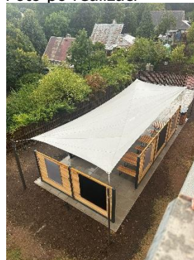
Foto po realizaci
