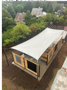
Foto po realizaci
