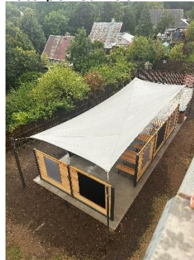
Foto po realizaci
