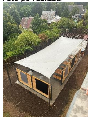
Foto po realizaci
