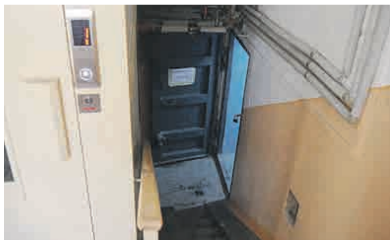
Vstup do bunkru v suterénu.
